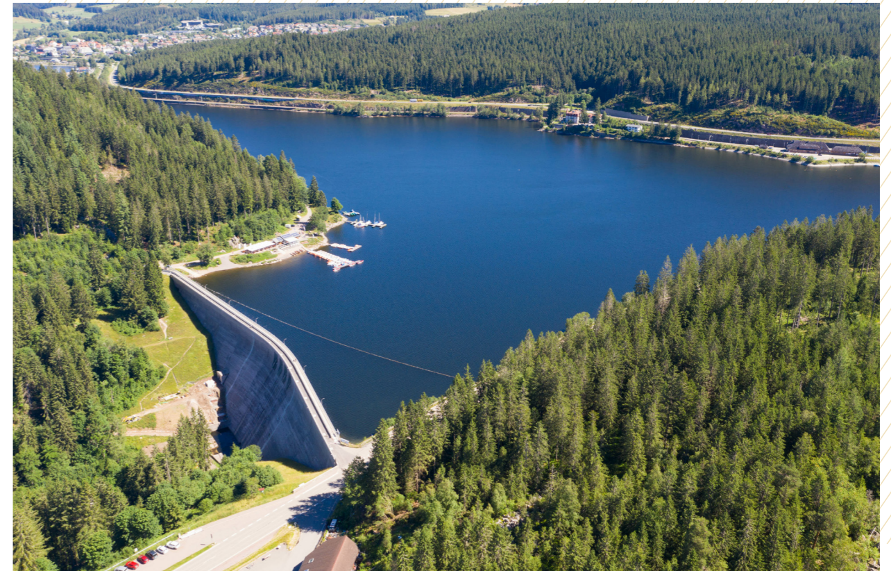
Der Schluchsee im südlichen Schwarzwald gilt als Deutschlands größter Stromspeicher
